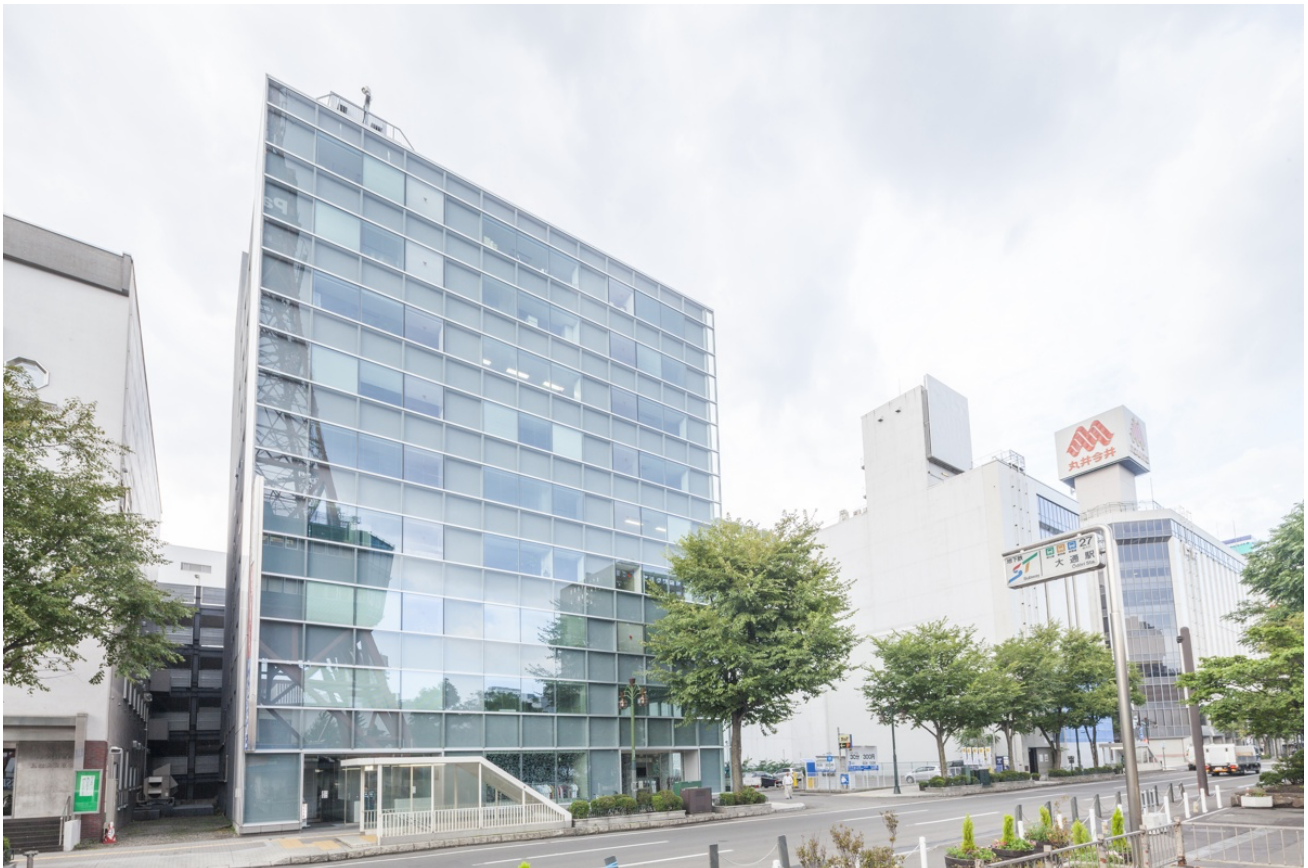
<サイボウズ札幌オフィスの外観写真>
