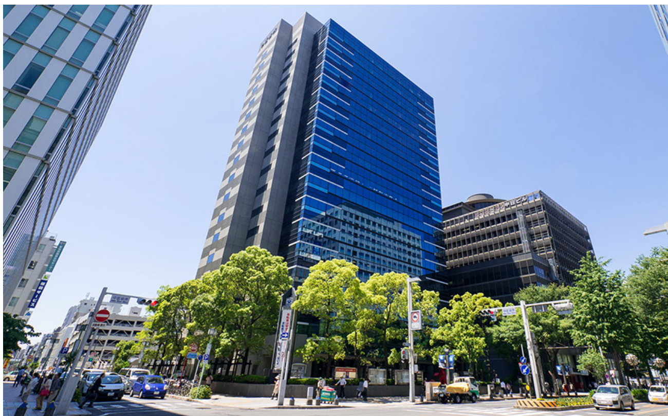
<サイボウズ名古屋営業所の外観写真>
